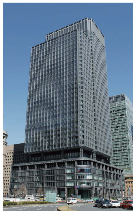
新丸ビル外観
